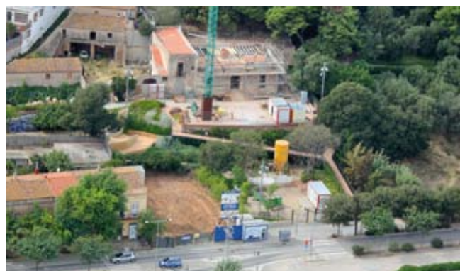
Obres a Can Julià, un dels 4 equipaments ambientals
