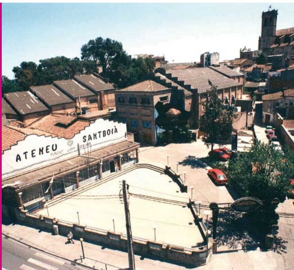
Imatge d'arxiu de l'Ateneu Santboià abans de la demolició de l'edifici principal
