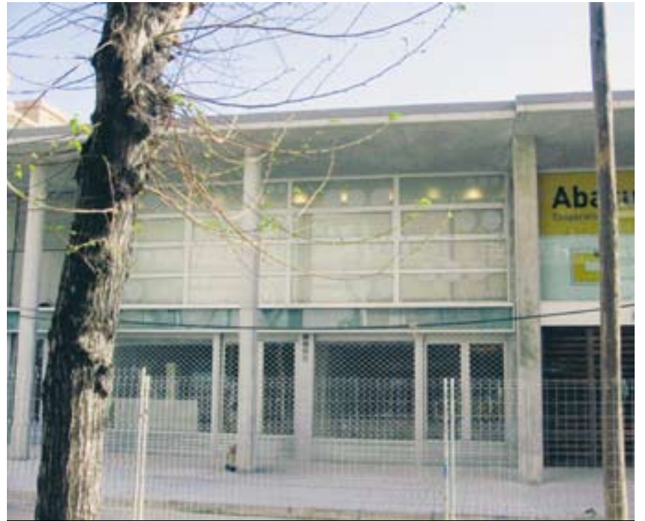
Façana del nou Mercat de Sant Jordi al carrer Francesc Macià
